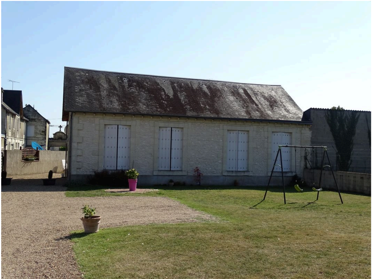
Bâtiment abritant les anciennes salles de classe.
