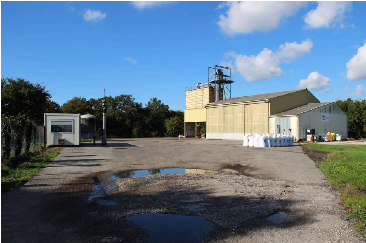
Installations de l'entreprise Adena (produits agricoles : semences, engrais), route de Soulac.
