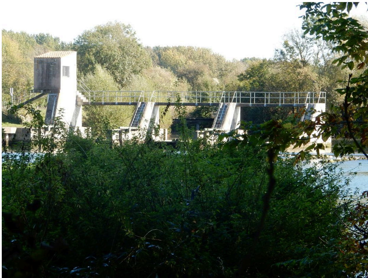
Les vannes vues du sud-ouest.
