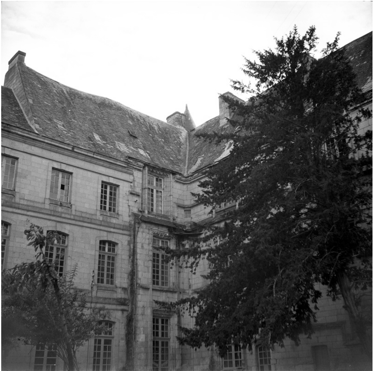
Jonction entre le logis Renaissance et la façade classique (élévation nord).
