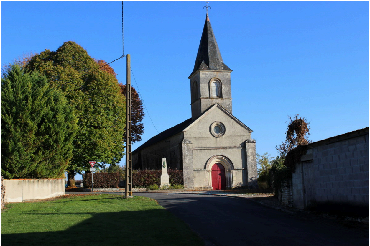
Une vue de l'église, depuis le nord-ouest.
