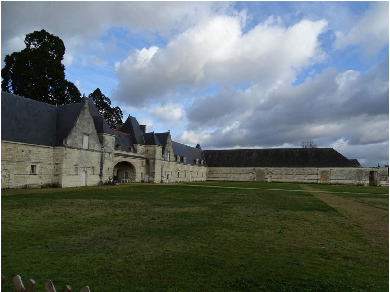
Vue des communs : aile est et nord.
