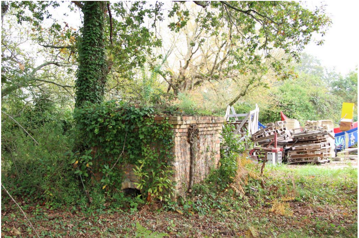
Vestige d'une installation artisanale : socle en brique, rue des Pêcheurs.
