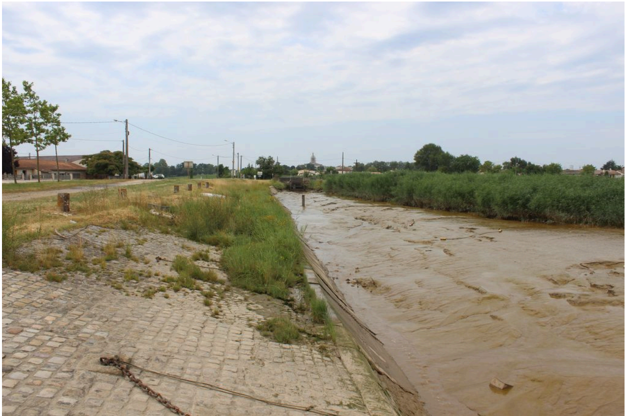
Vue d'ensemble de la cale inclinée et de l'estey envasé.
