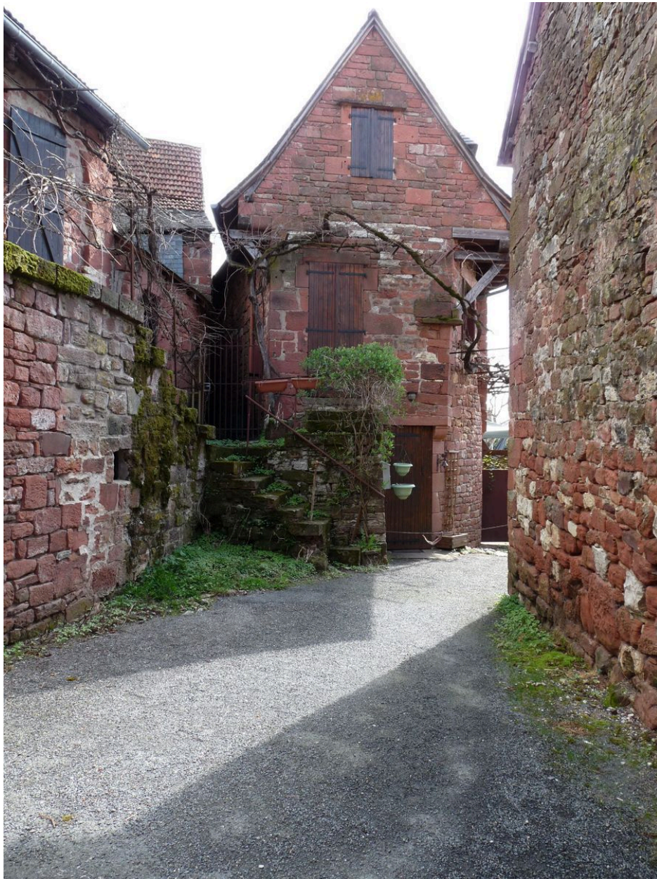
Vue générale de l'élévation ouest.
