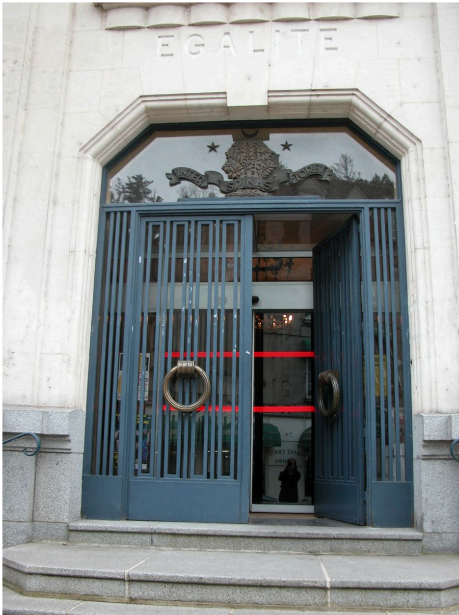
Détail de la porte d'entrée.
