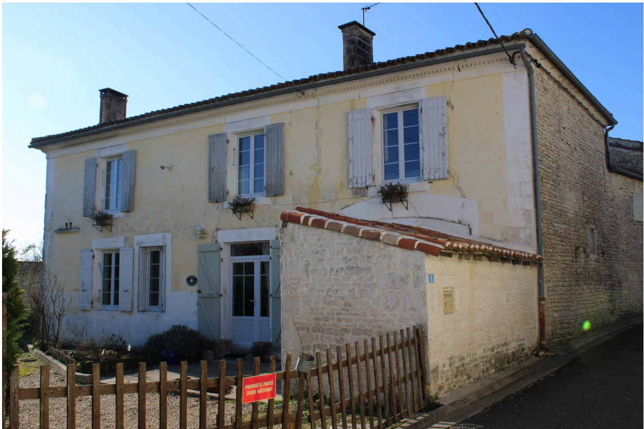
Une vue du logement de l'ancienne ferme, depuis le nord-est.
