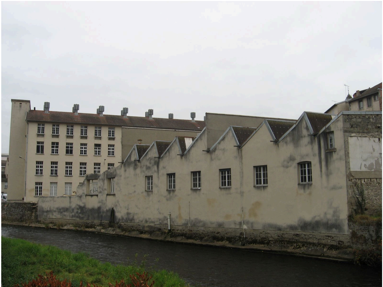
Vue générale des sheds Philips en cours de destruction (novembre 2007), prise depuis le quai des Iles.
