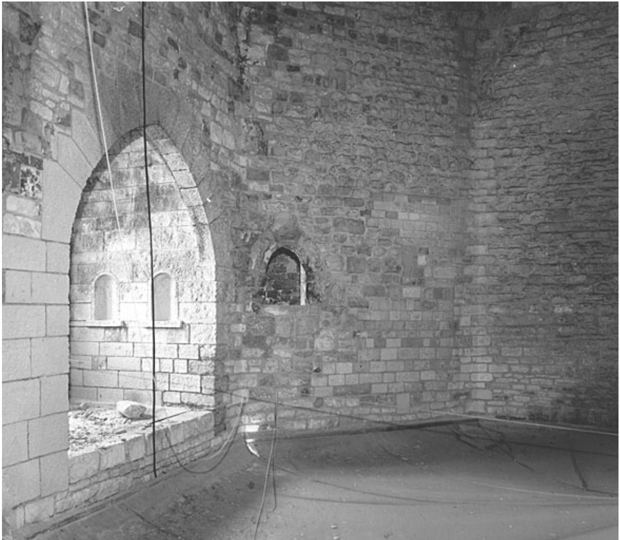
Intérieur, troisième niveau, salle annexe ouest.
