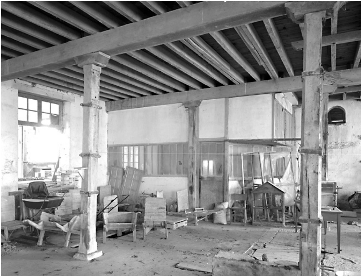
Bâtiment des fours de 1872, intérieur et local de la machine à vapeur, vue vers le sud.
