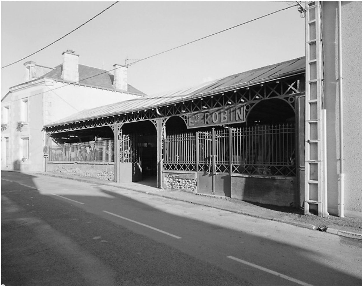
Entrepôt vu de l'ouest.
