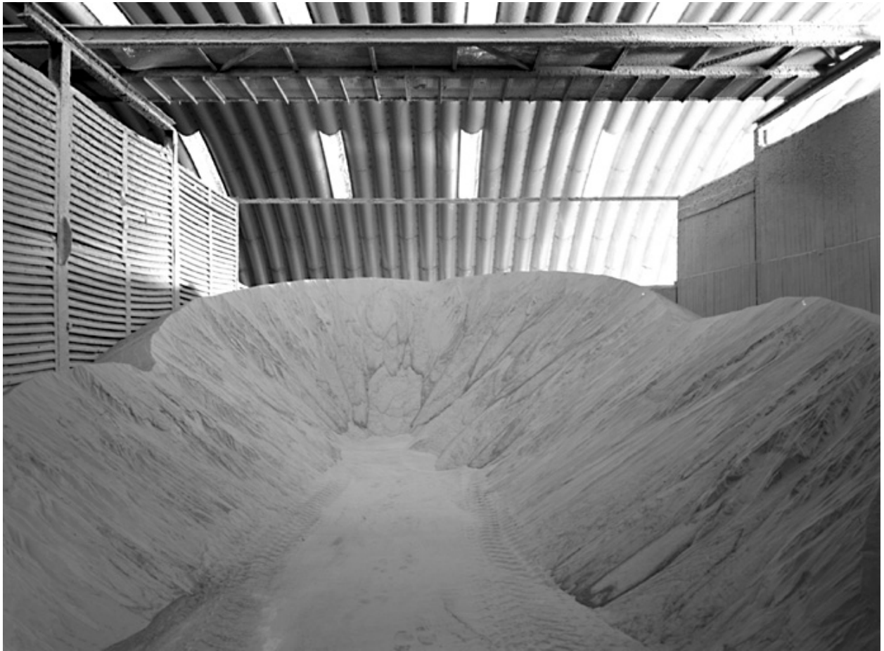
Vue intérieure de l'entrepôt des matières organiques.
