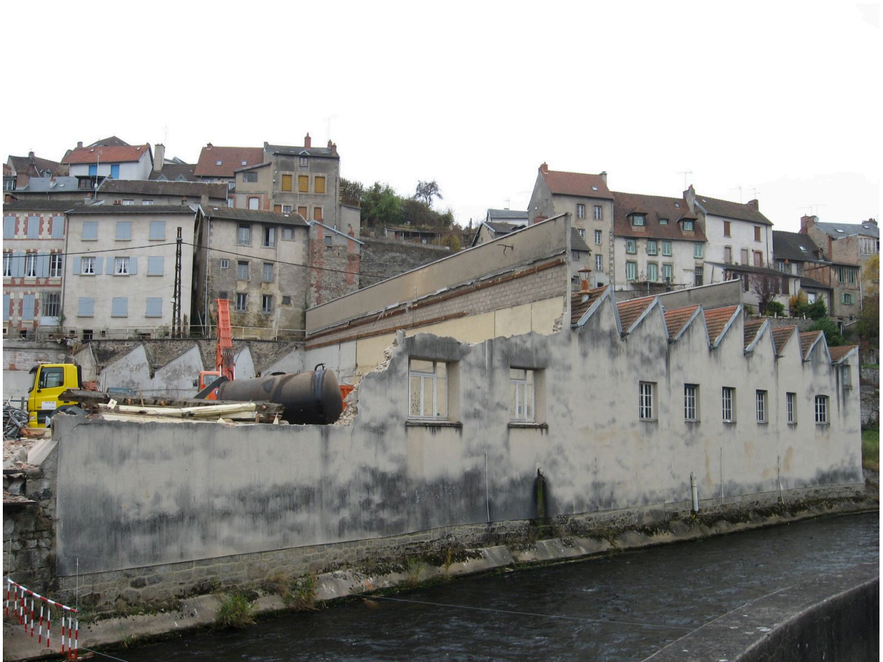
Vue générale des sheds Philips en cours de destruction (novembre 2007).
