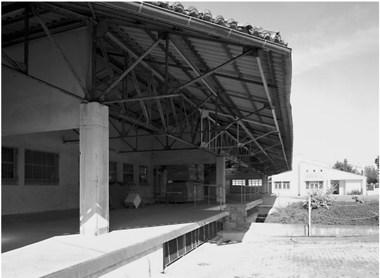
Quais de déchargement vus de l'est.
