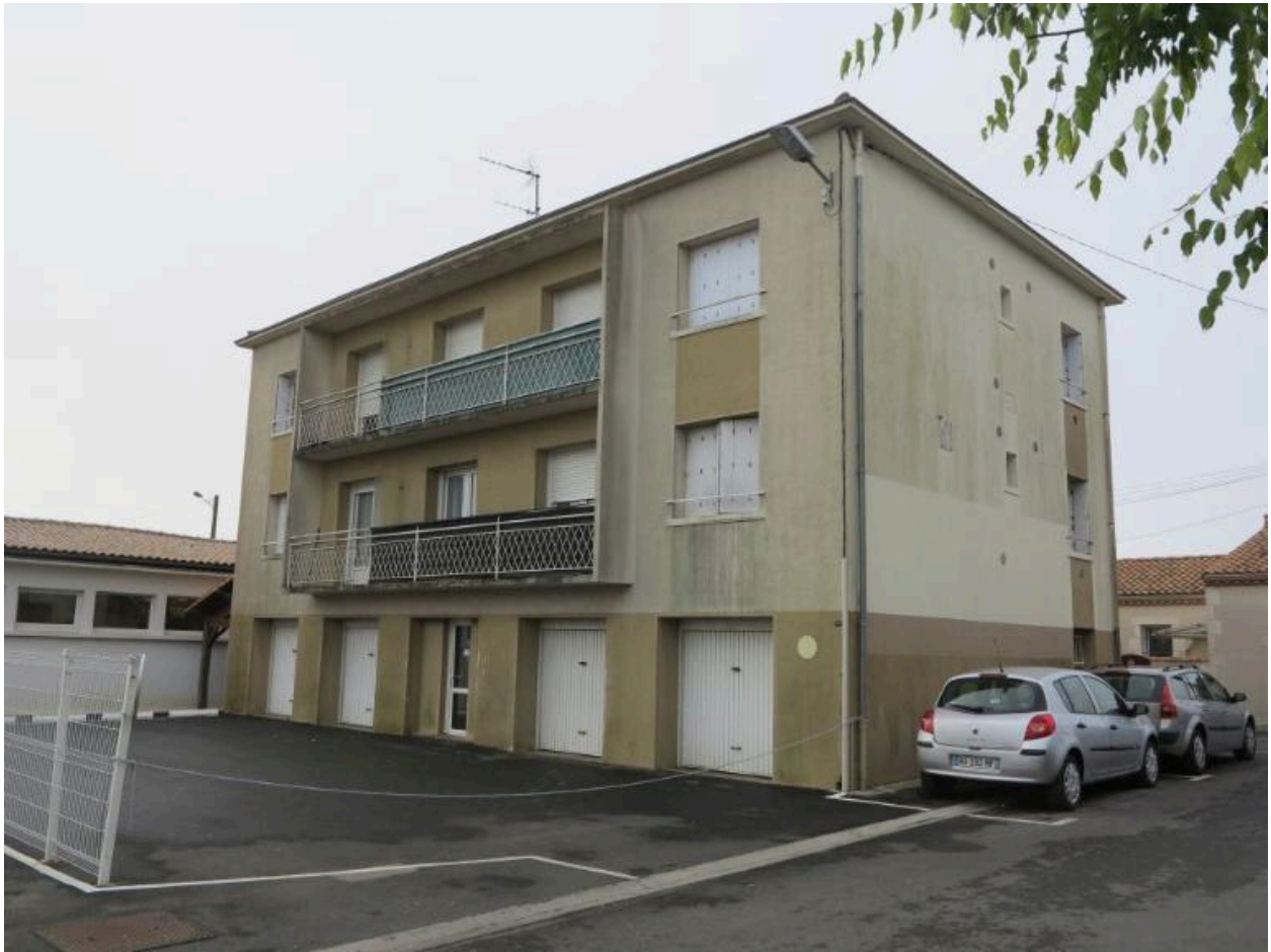
L'immeuble des logements d'enseignants, au sud-ouest de l'ensemble, vu depuis le nord.
