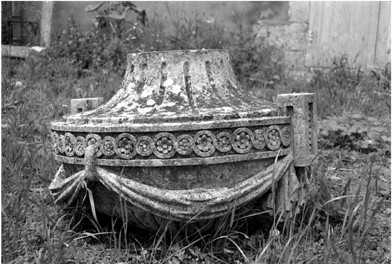
Amortissement d'un pilier.
