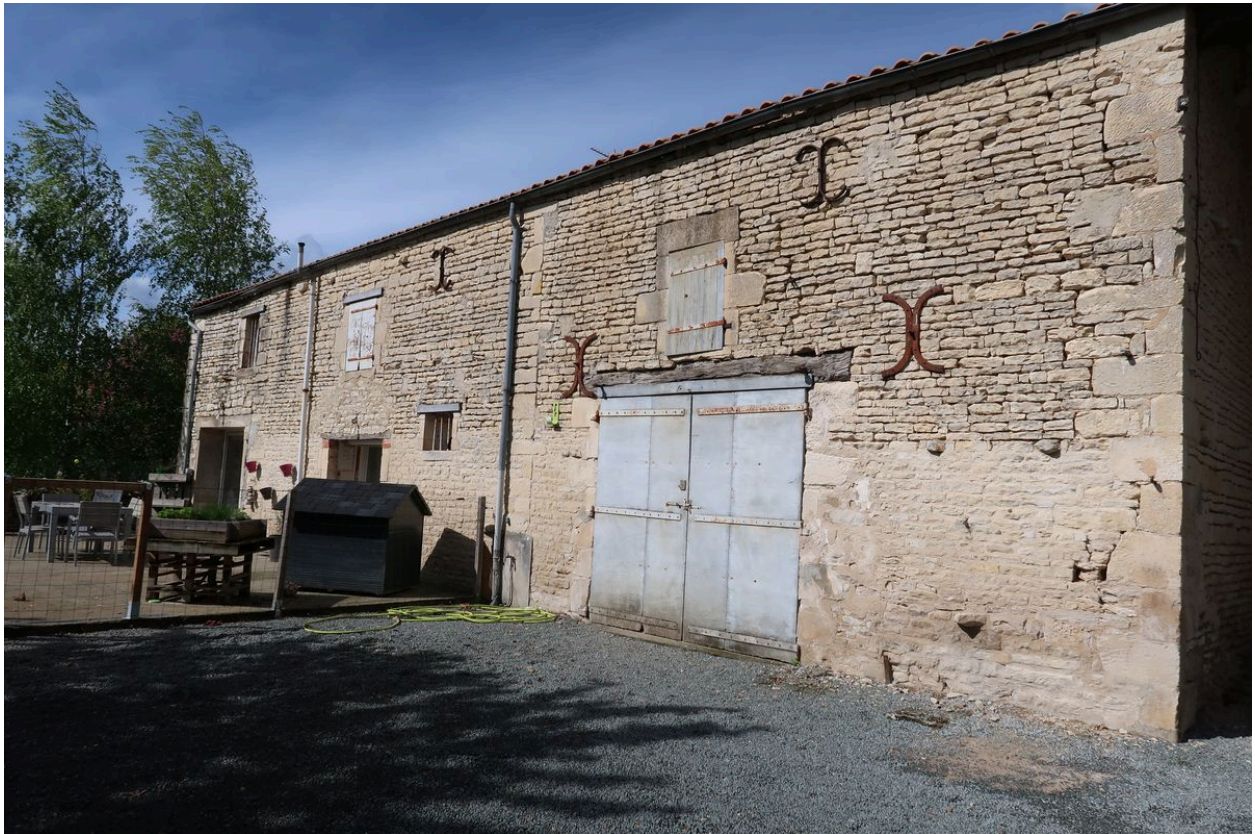
Vue de la façade sur cour.
