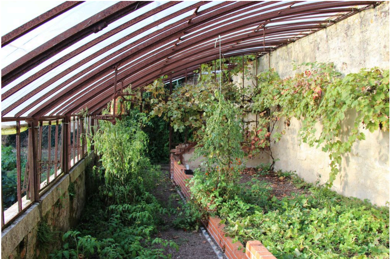
Serre : vue intérieure.
