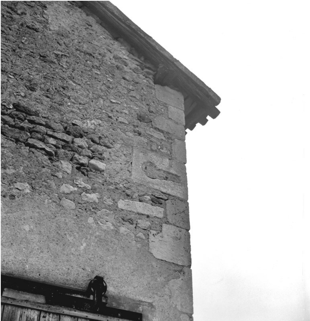
Canonnière en remploi dans le chaînage d'angle d'une grange à Isse, en 1976.
