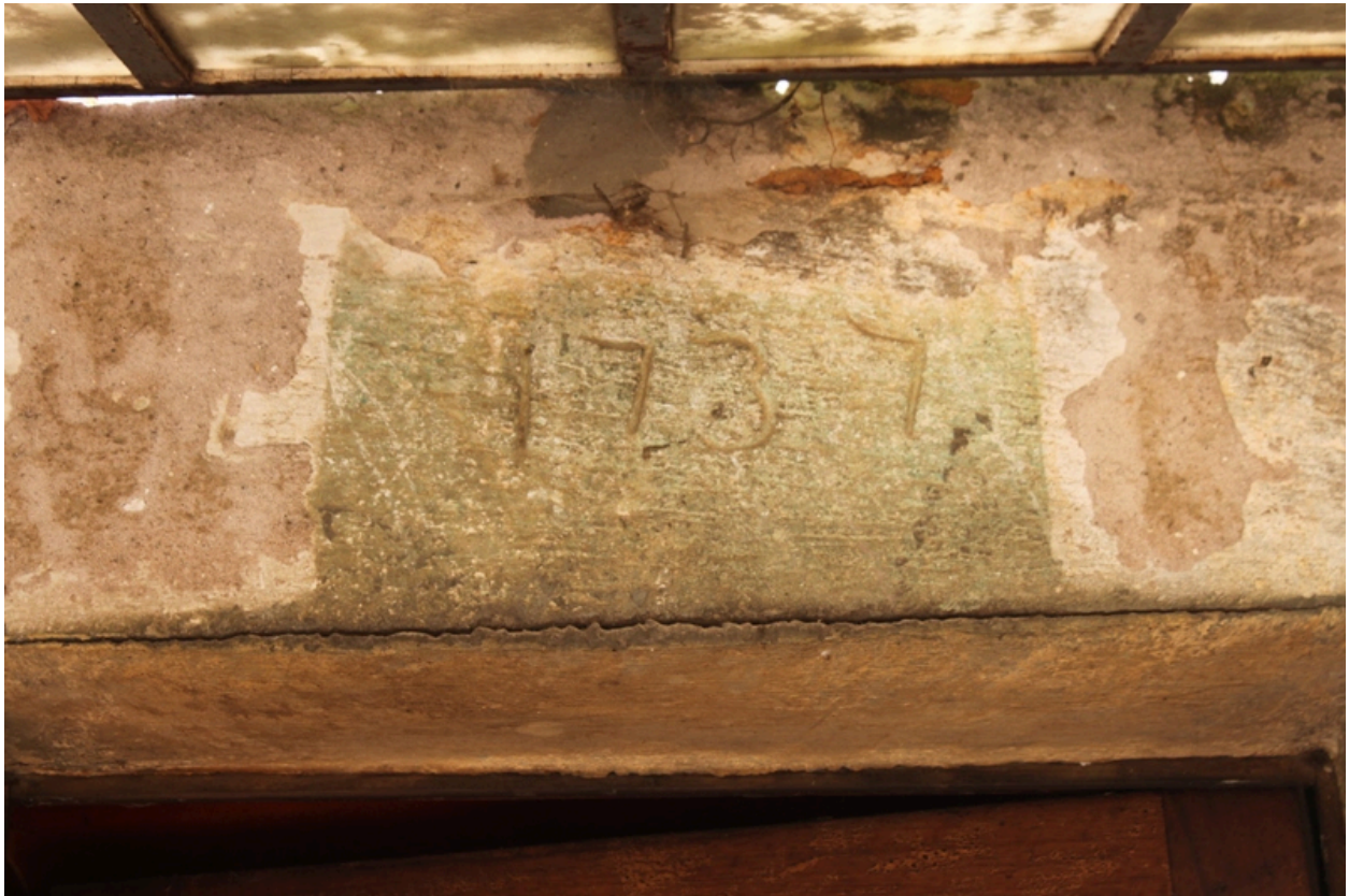
Linteau de porte d'un logis de ferme : 1737
