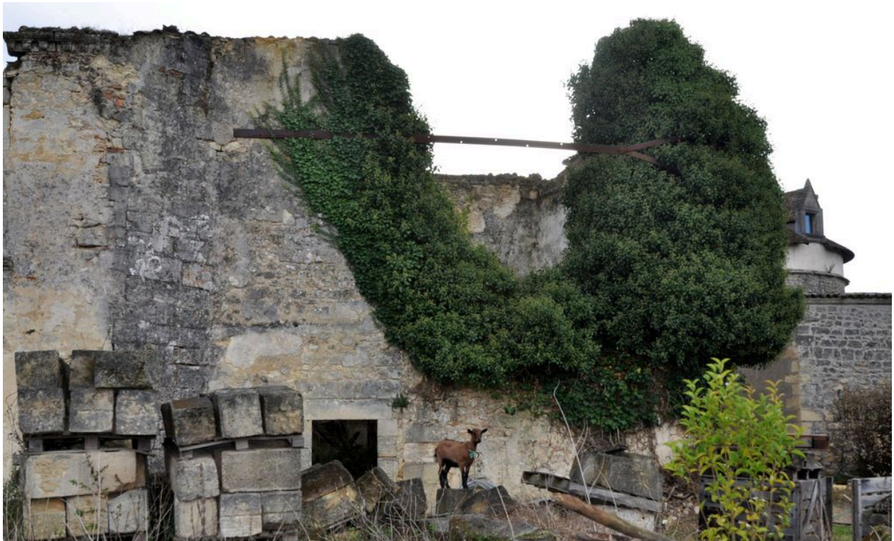
Corps de logis, élévation ouest : partie sud.
