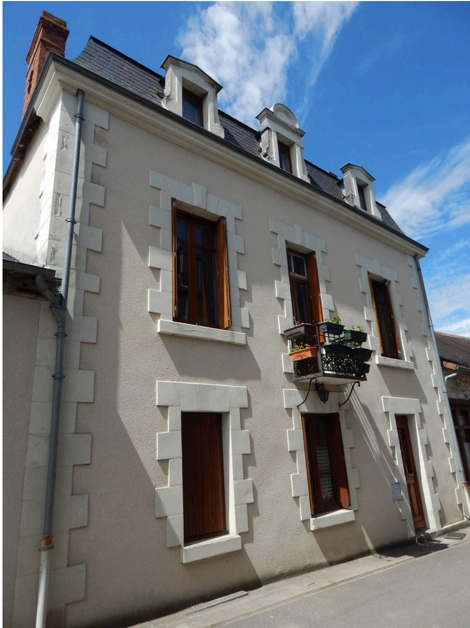
Élévation orientale de l'habitation.
