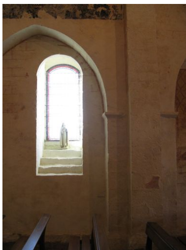
Nef, intérieur, troisième travée, mur sud. Baie couverte d'un arc segmentaire. Phot. Christine Sarrazin IVR54_20098603986NUCA
