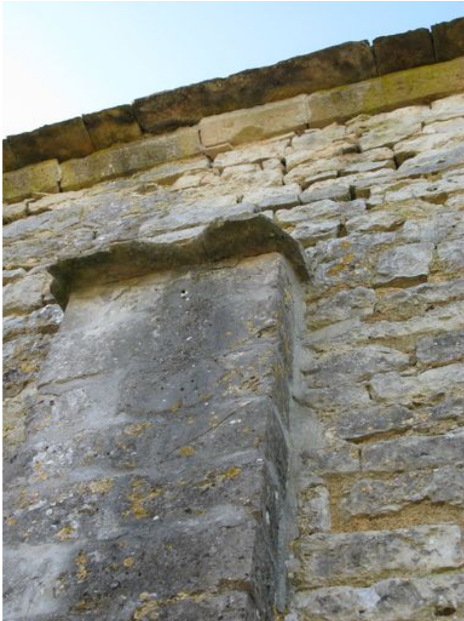
Nef, élévation nord, contrefort central, détail.
