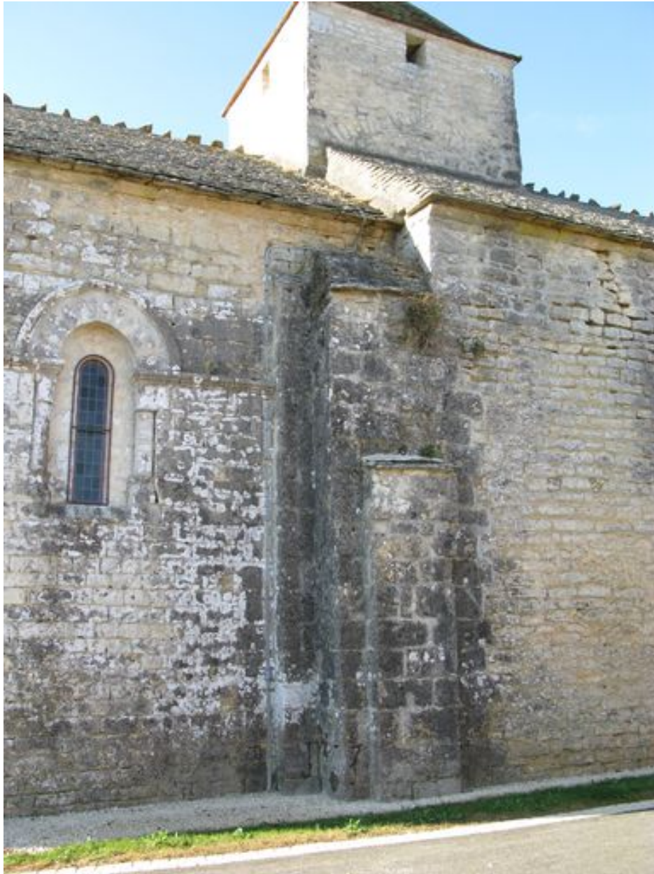
Chevet, travée droite, mur nord, extrémité ouest, contrefort.
