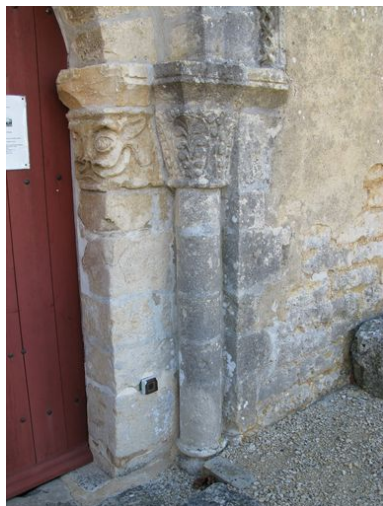
Façade occidentale, portail, piédroit droit. Phot. Christine Sarrazin IVR54_20098603978NUCA
