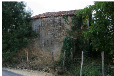
Le hangar agricole, depuis le nord-ouest. Phot. Pierrick Barreau IVR54_20131712659NUCA
