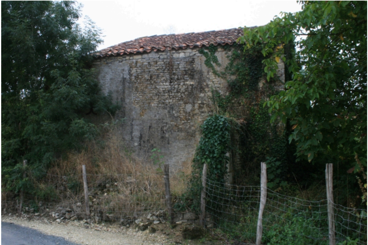
Le hangar agricole, depuis le nord-ouest.
