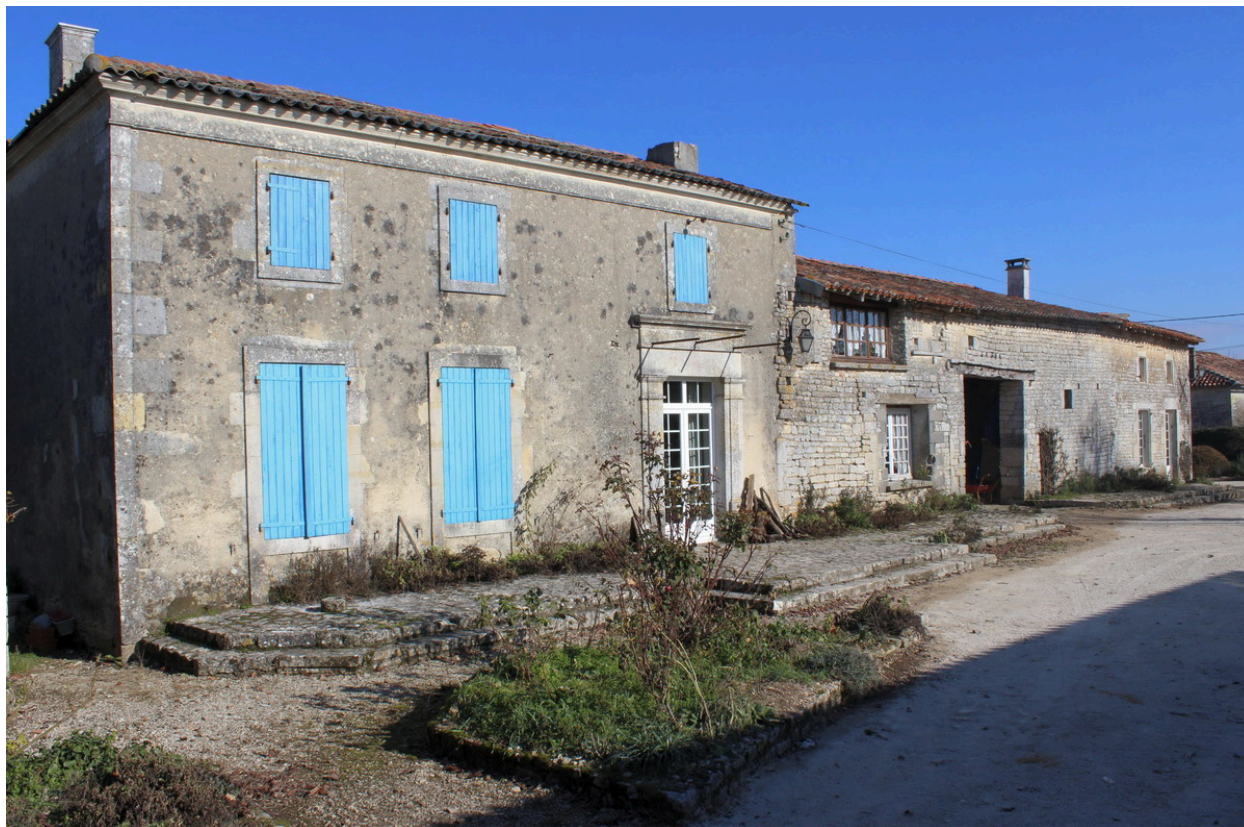
Une vue du corps principal de l'ancienne ferme, depuis le sud-ouest.
