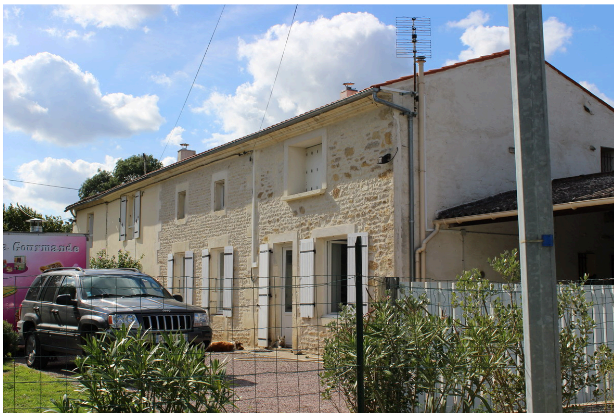
Une vue des deux maisons, au premier plan, depuis le sud-est.
