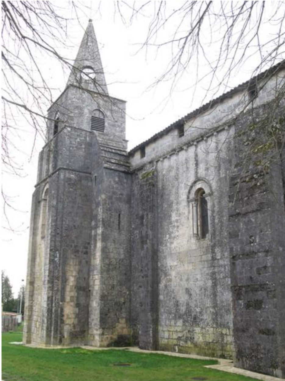
Élévation nord de la nef et clocher.
