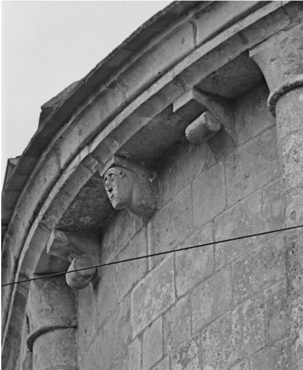
Travée sud de l'abside. Modillons 1 à 3. Cliché de 1987.
