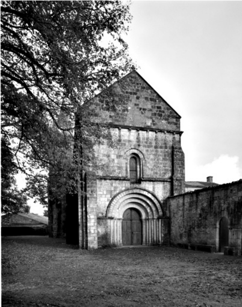
Façade ouest. Cliché de 1987.
