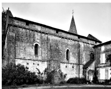
Élévation sud de la nef. Cliché de 1987. Phot. Mariusz Hermanowicz IVR54_19871601823V
