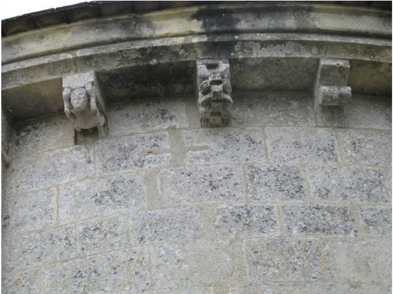
Travée nord de l'abside. Modillons 13 à 15.
