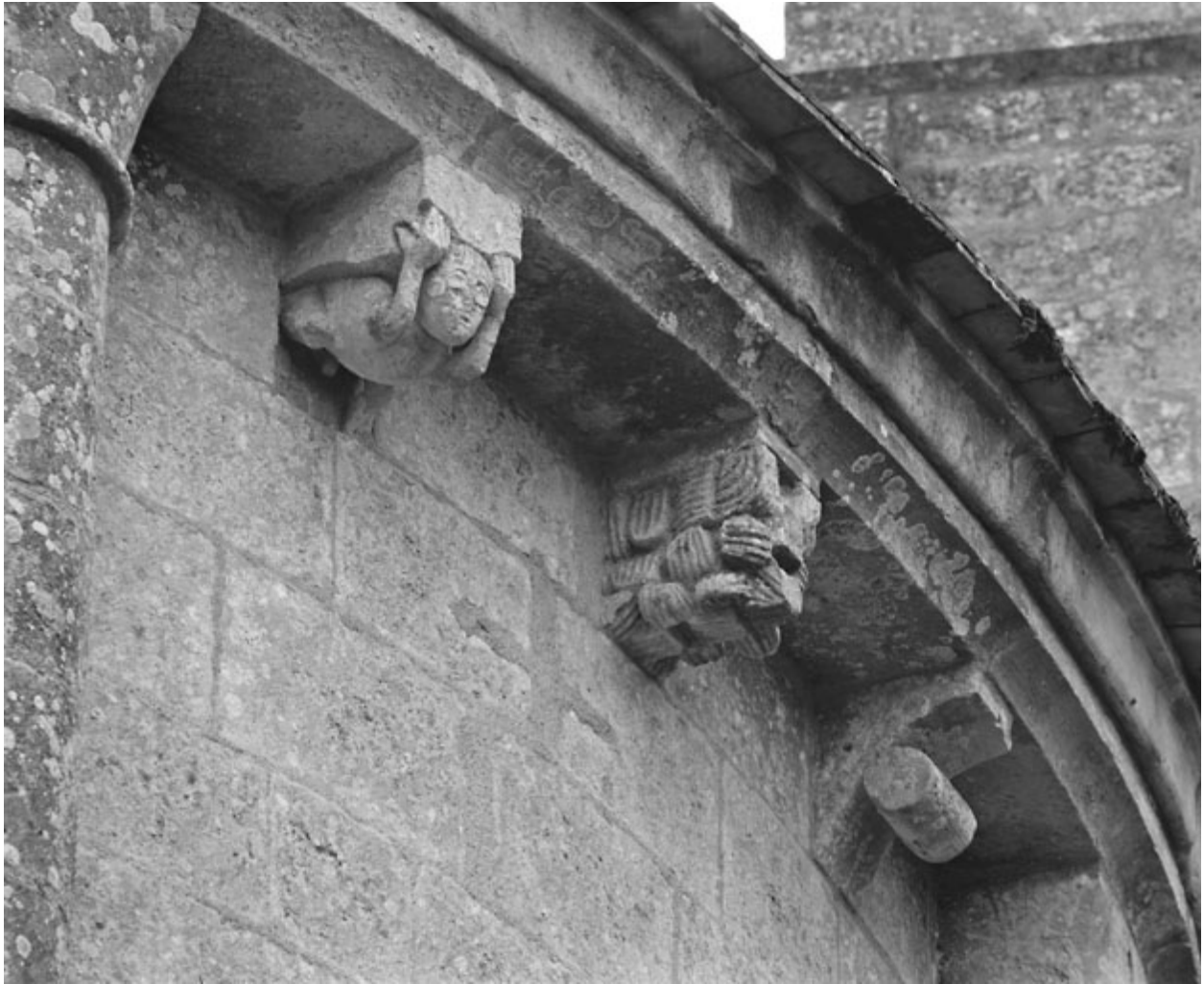
Travée nord de l'abside. Modillons 13 à 15. Cliché de 1987.
