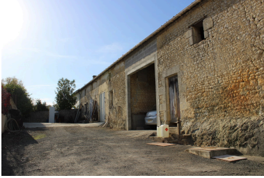
Une vue d'ensemble. Phot. Pierrick Barreau IVR54_20171709965NUCA
