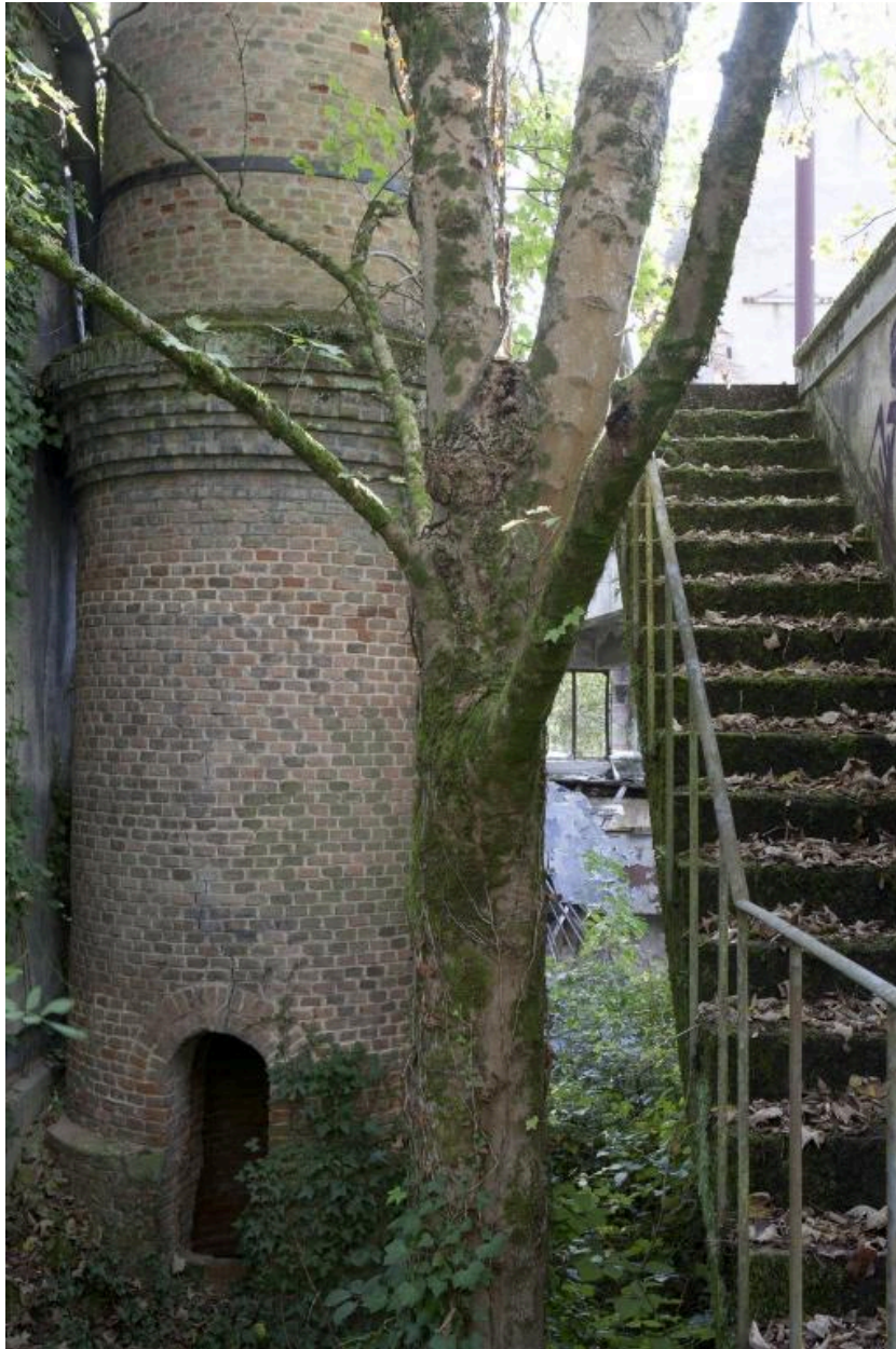
souche de la cheminée de la mégisserie Lagarde.
