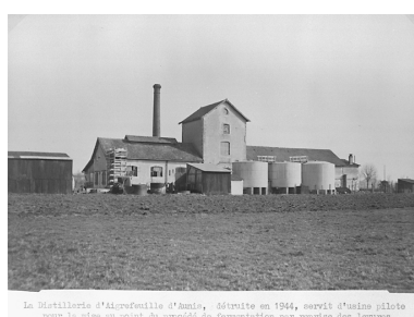
Vue de l'ensemble, avant la destruction en 1944. Phot. Alain (reproduction) Maulny IVR54_19911700409X
