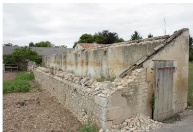
D'anciens toits à bêtes, depuis le sud-est. Phot. Cécilia Guiberteau IVR54_20091701596NUCA
