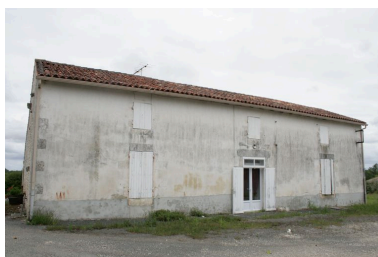
Le logement de la ferme, depuis le nord-ouest. Phot. Cécilia Guiberteau IVR54_20091701594NUCA
