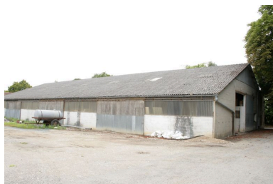
Un hangar agricole, depuis le nord-est. Phot. Cécilia Guiberteau IVR54_20091701602NUCA
