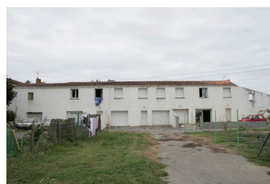
D'anciennes dépendances réhabilitées en logements, depuis le sud-ouest. Phot. Cécilia Guiberteau IVR54_20091701597NUCA
