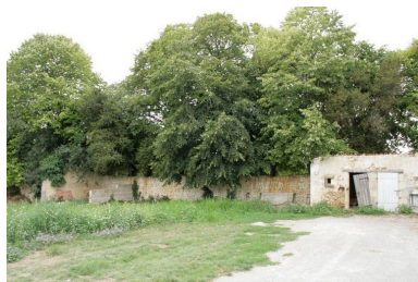
Des dépendances et un toit à bêtes, depuis le nord-ouest. Phot. Cécilia Guiberteau IVR54_20091701598NUCA
