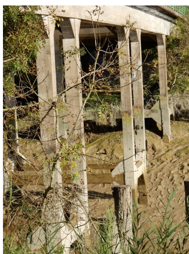
Détail des poteaux en béton armé. Phot. Pascale Moisson IVR54_20171704774NUCA
