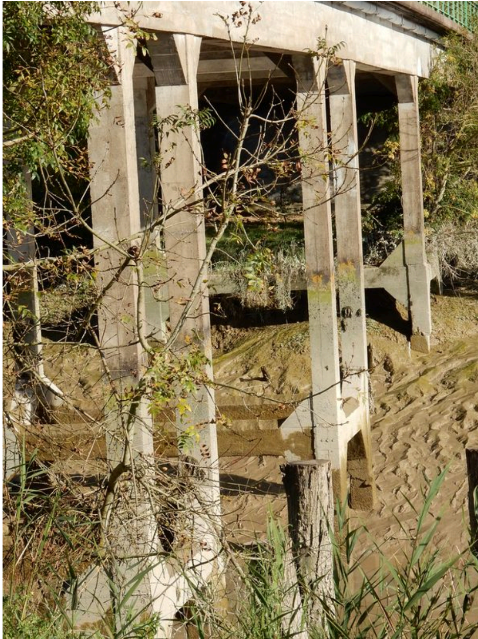
Détail des poteaux en béton armé.
