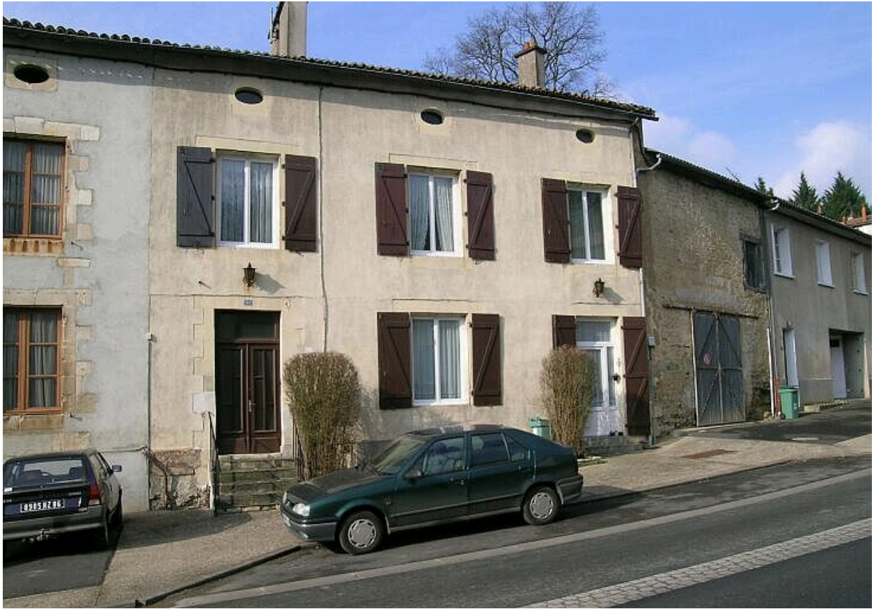
Elévations sur rue, partie droite.
