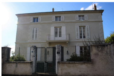
La façade principale de la maison, depuis l'est. Phot. Nathalie Lhuissier IVR75_20181703336NUCA
