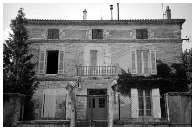
La façade sur rue de la maison. Phot. Nathalie Lhuissier IVR54_20001704485Z
