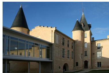
Château Saugeron : vue de l'aile ouest et du pavillon d'angle depuis la cour au sud-est. Phot. Alain Beschi IVR72_20113306462NUC2A
