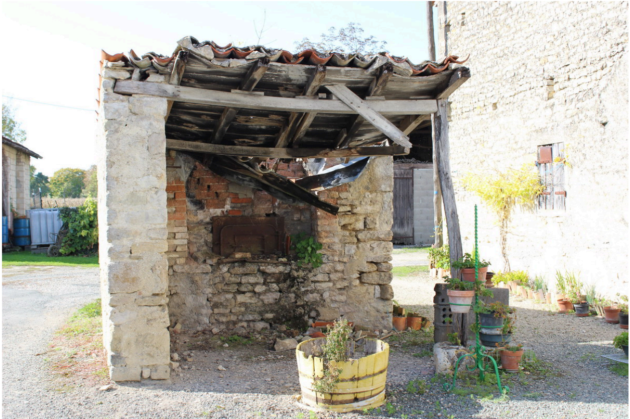
Une vue du four, depuis l'ouest.
