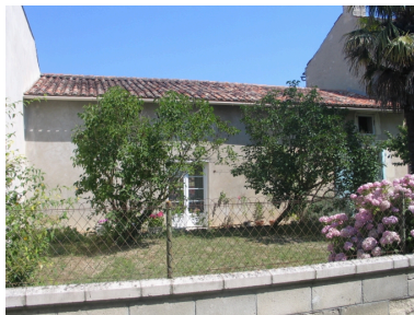
La dépendance accolée à gauche du logement. Phot. Nathalie Lhuissier, Phot. Cécilia Guiberteau IVR54_20051705690NUCA
