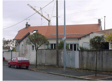
Façade postérieure vue depuis la rue Jacques-Henry. Phot. Yann Cussey IVR54_20071704370NUCA
