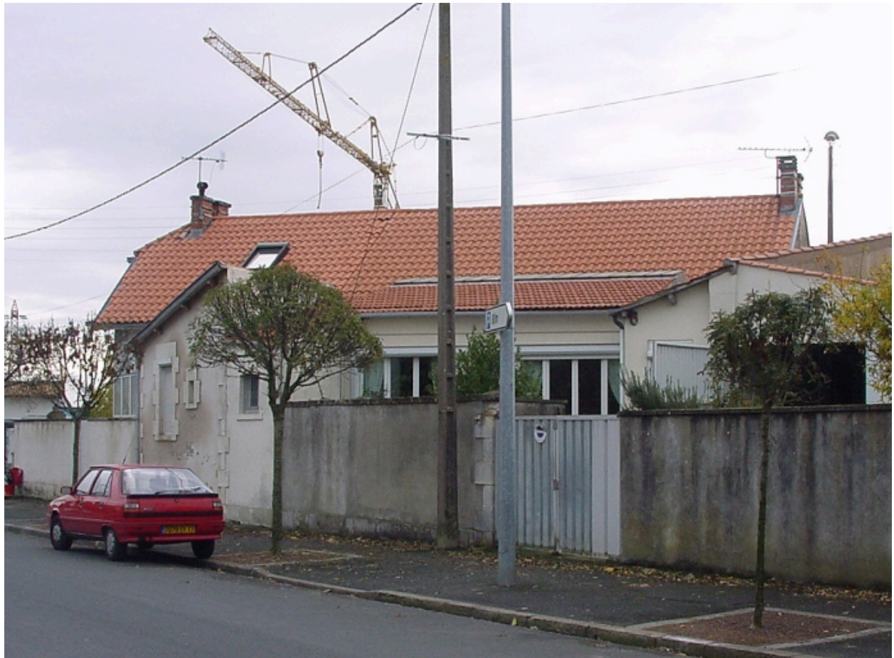
Façade postérieure vue depuis la rue Jacques-Henry.
