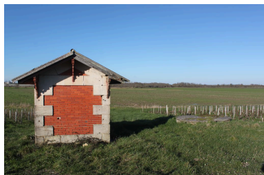
Puits et cabane. Phot. Claire Steimer IVR72_20163302272NUC2A
