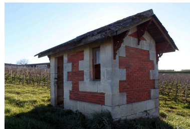
Façade est avec porte d'accès. Phot. Claire Steimer IVR72_20163302274NUC2A
