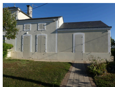
Façade, orientée au sud, de la mairie de la commune de Vergné. Phot. Océane Charruyer IVR75_20211706003NUCA
