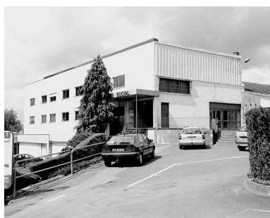
Vue de l'atelier construit dans les années 1960 prise du sud-ouest. Phot. Raphaël Jean IVR54_20037900525X
