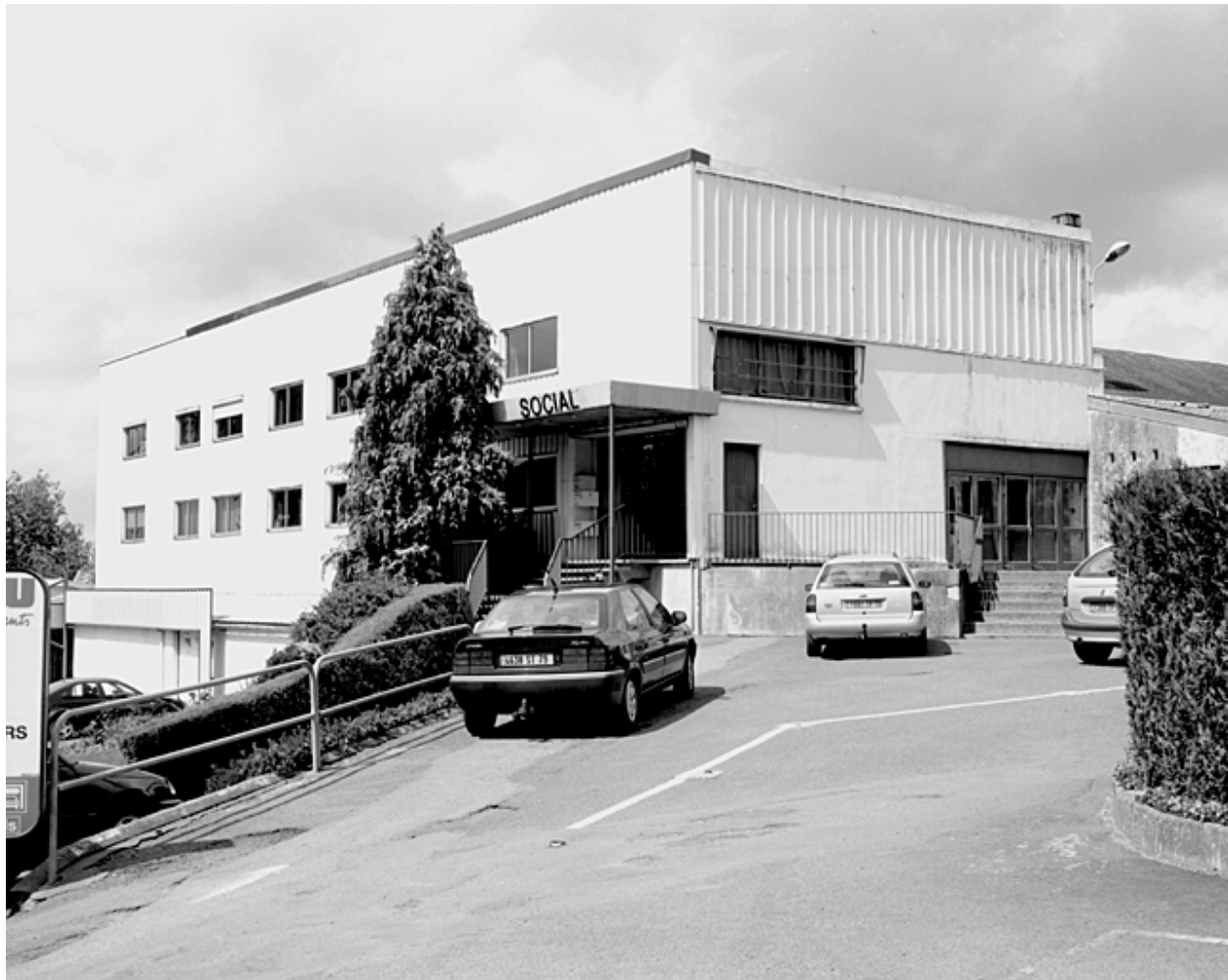
Vue de l'atelier construit dans les années 1960 prise du sud-ouest.
