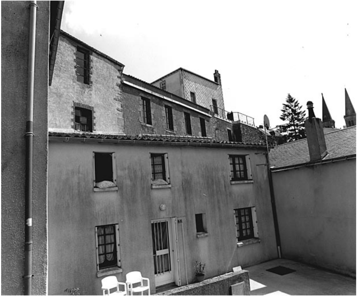
Premier atelier de l'entreprise vu de la rue de l'Escalier.
