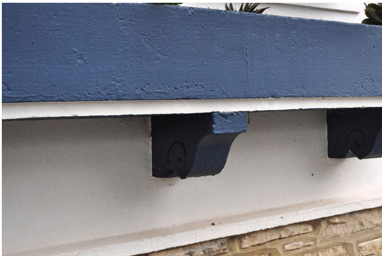
Façade principale, console de la jardinière.
