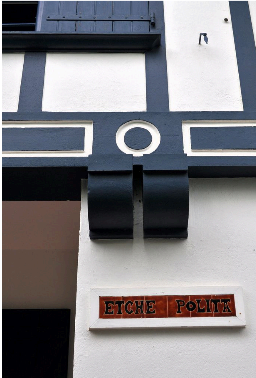
Façade principale, détail du faux pan de bois et céramique.
