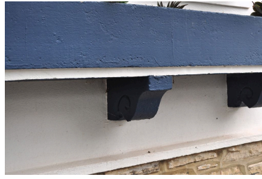
Façade principale, console de la jardinière. Phot. Maïté Ehlinger IVR72_20196403986NUC2A
