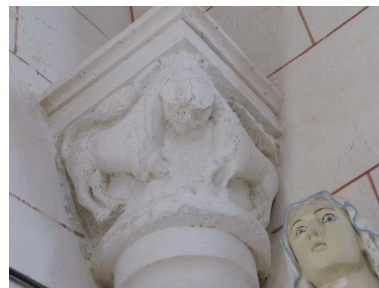
Angle nord-est de la nef, chapiteau remployé en console, détail : lions affrontés. Phot. Christine Sarrazin IVR54_20098604129NUCA
