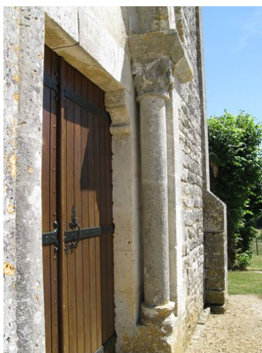
Façade occidentale, portail, piédroit droit, vue de profil. Phot. Véronique Dujardin IVR54_20098603629NUCA
