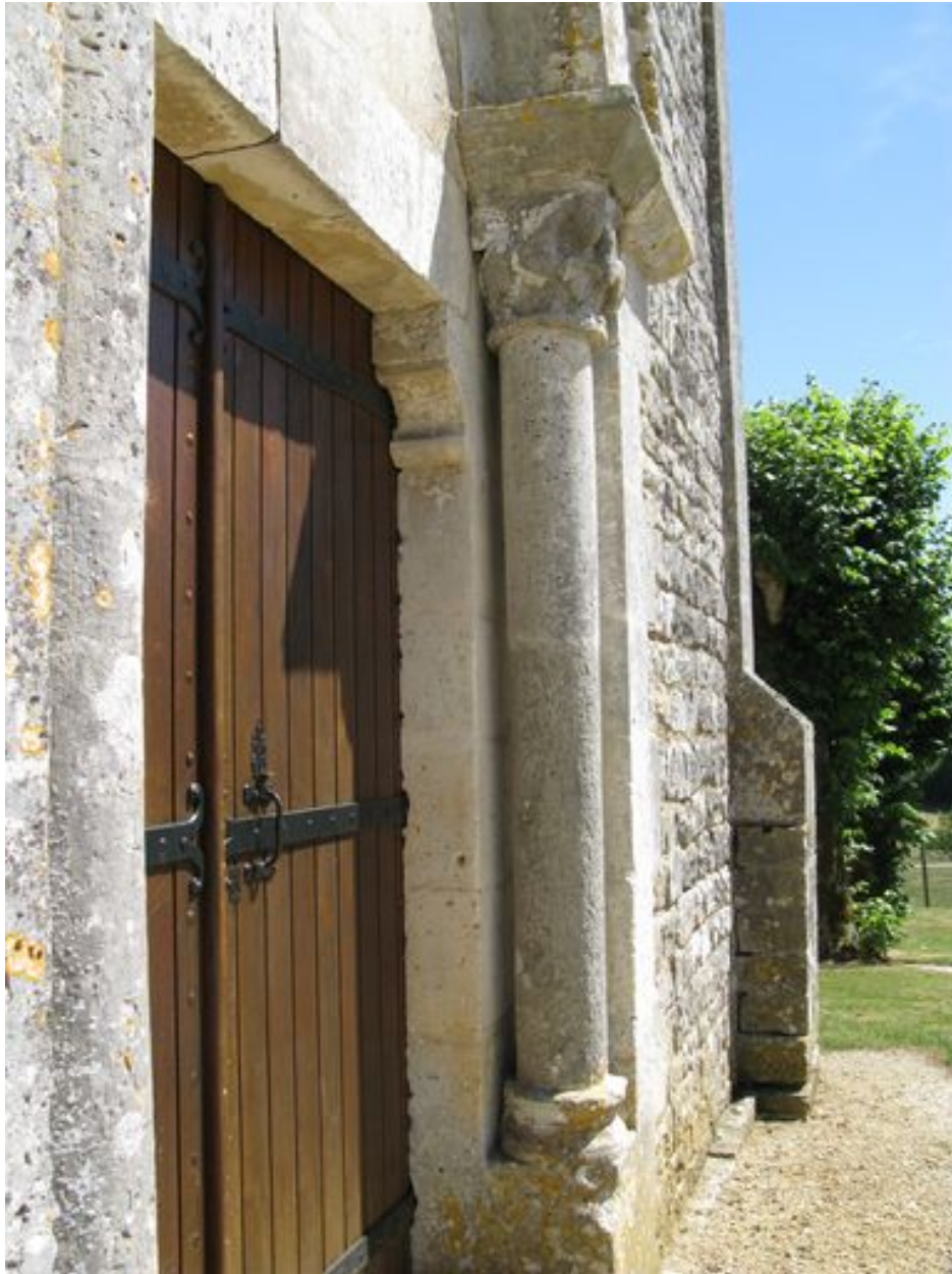
Façade occidentale, portail, piédroit droit, vue de profil.
