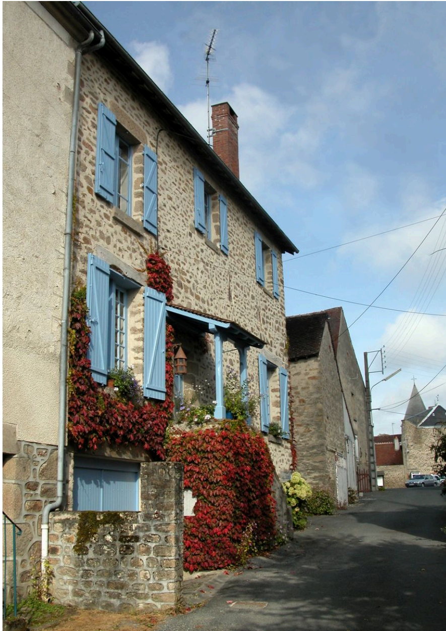
Vue générale de la façade côté rue à l'est.
