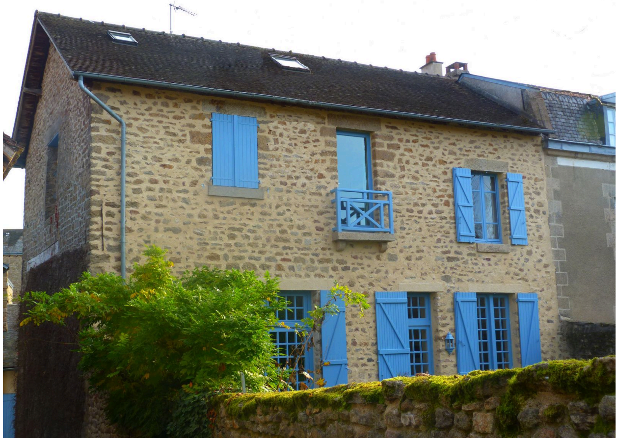
Façade côté jardin à l'ouest.
