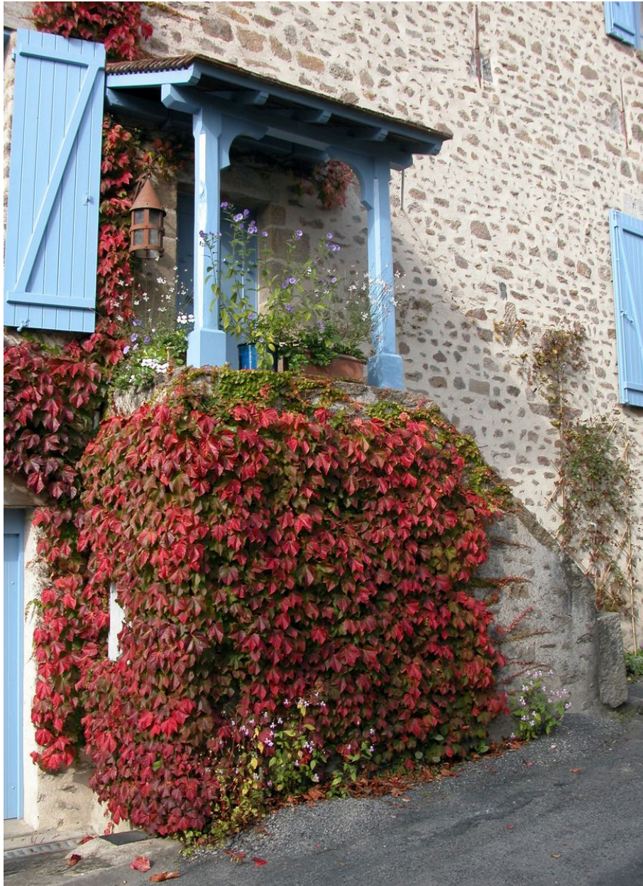
L'escalier extérieur couvert, façade est.
