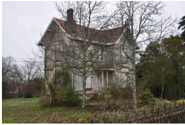
Façade sud-ouest et pignon nord-ouest. Phot. Claire Steimer IVR72_20103301039NUCA
