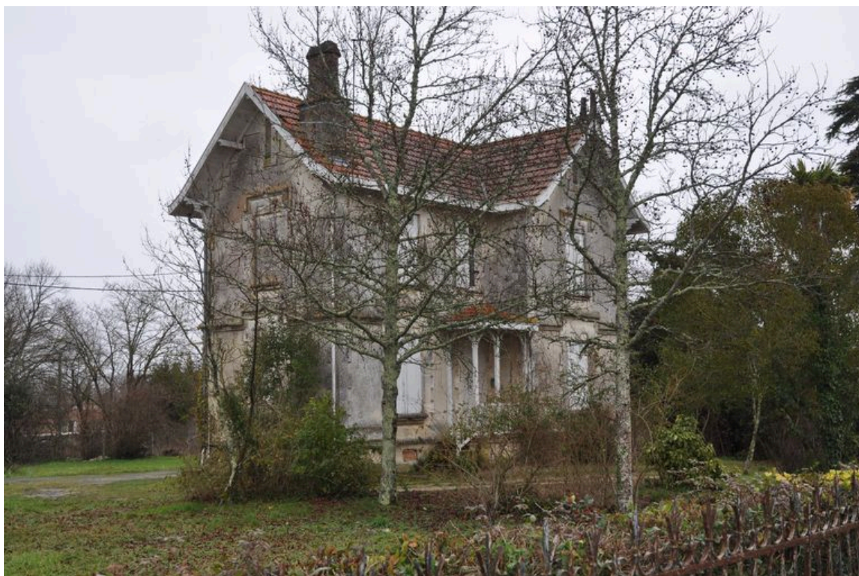
Façade sud-ouest et pignon nord-ouest.
