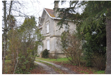
Façade sud-ouest. Phot. Claire Steimer IVR72_20103301041NUCA
