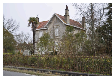
Façade sud-ouest. Phot. Claire Steimer IVR72_20103301038NUCA
