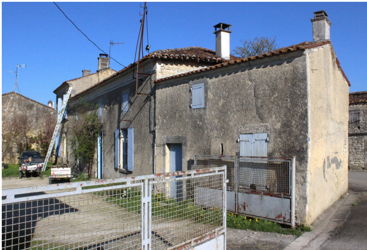
Une vue des trois logements de l'ancienne ferme, depuis le sud-est.
