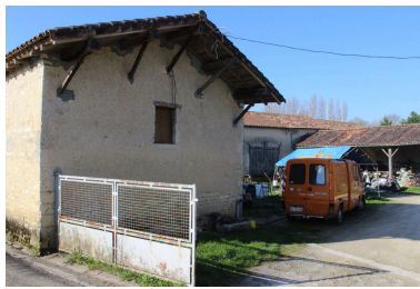
Une vue partielle des dépendances de l'ancienne ferme, depuis le nord-est.
